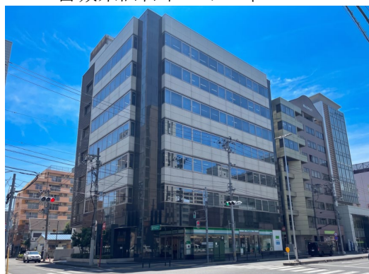
宮城県仙台市のオフィスビル
